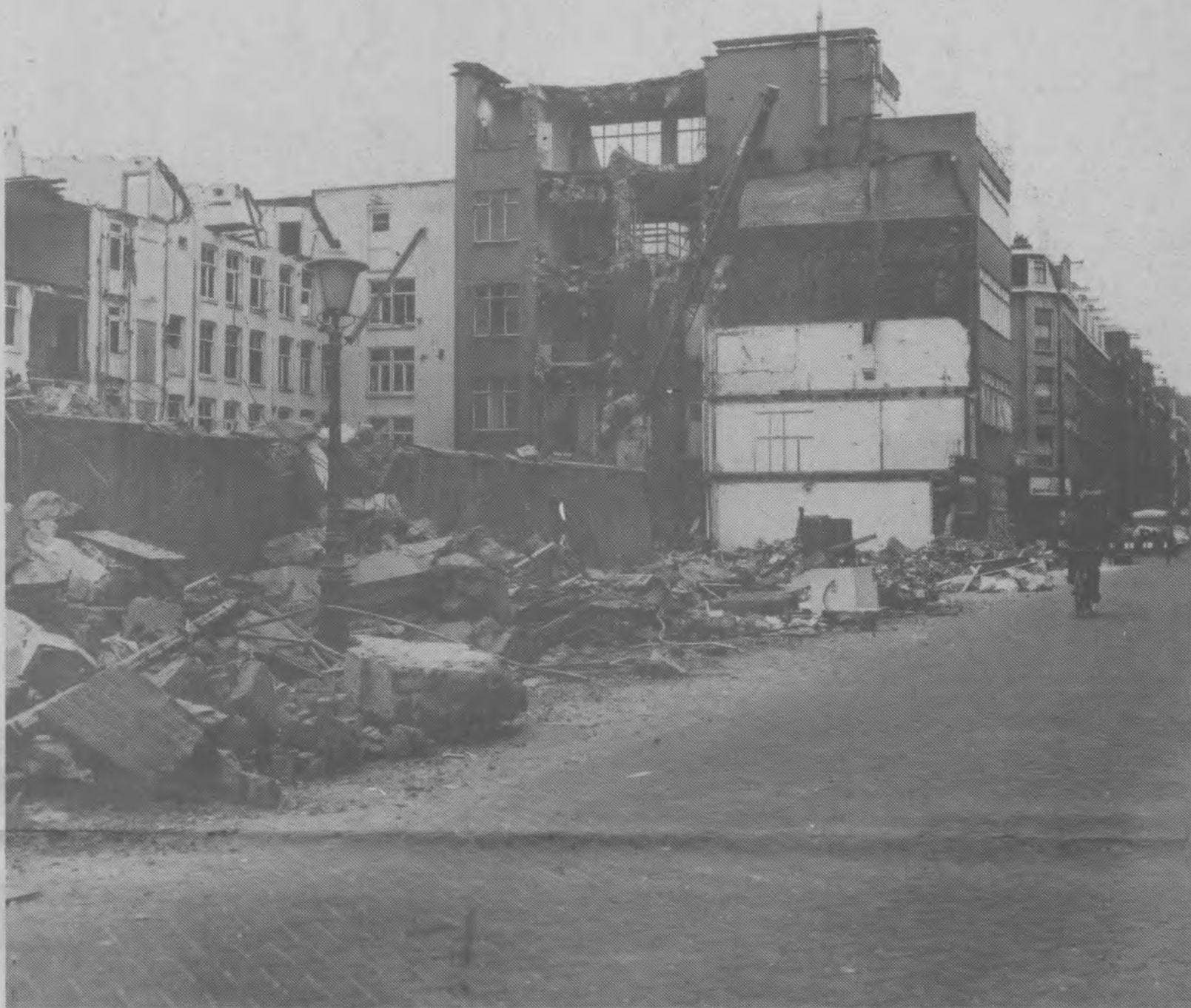
Begin 1973: sloop van de kinine-fabriek. (Foto: Spiekerman)
