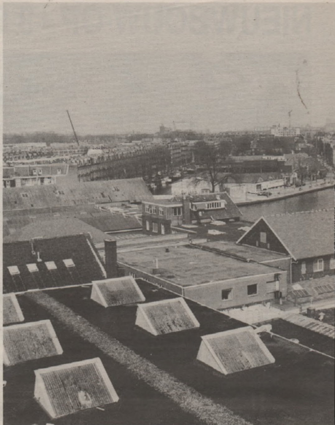
Het gebied gezien vanaf de Van Hallstraat in noordelijke richting, met op de voorgrond de bebouwing van het Expeditiecentrum van de PTT.
