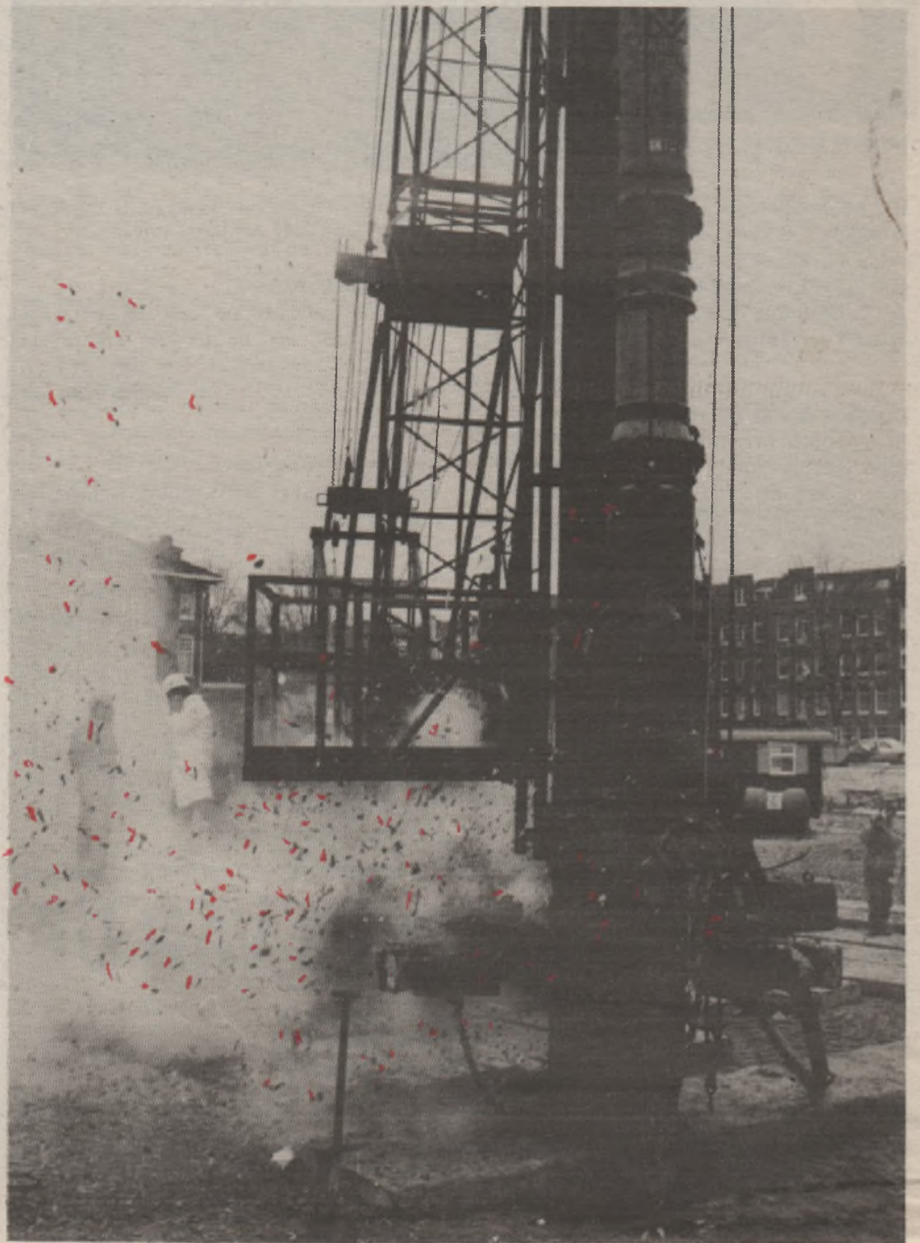
Op 11 december jl. werd de eerste paal geslagen voor het project „De Liefde” aan de Bilderdijkstraat. Met een knallend vuurwerk sloegen wethouder Genet en de voorzitter van het stadsdeel Oud West, mevrouw H. Dankbaar, de paal de grond in. foto: Hans Glimmerveen
