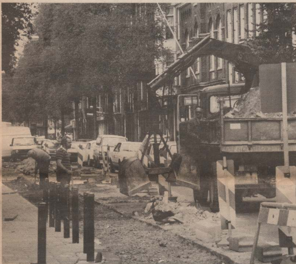
De werkzaamheden in de Spaarndammerstraat.
