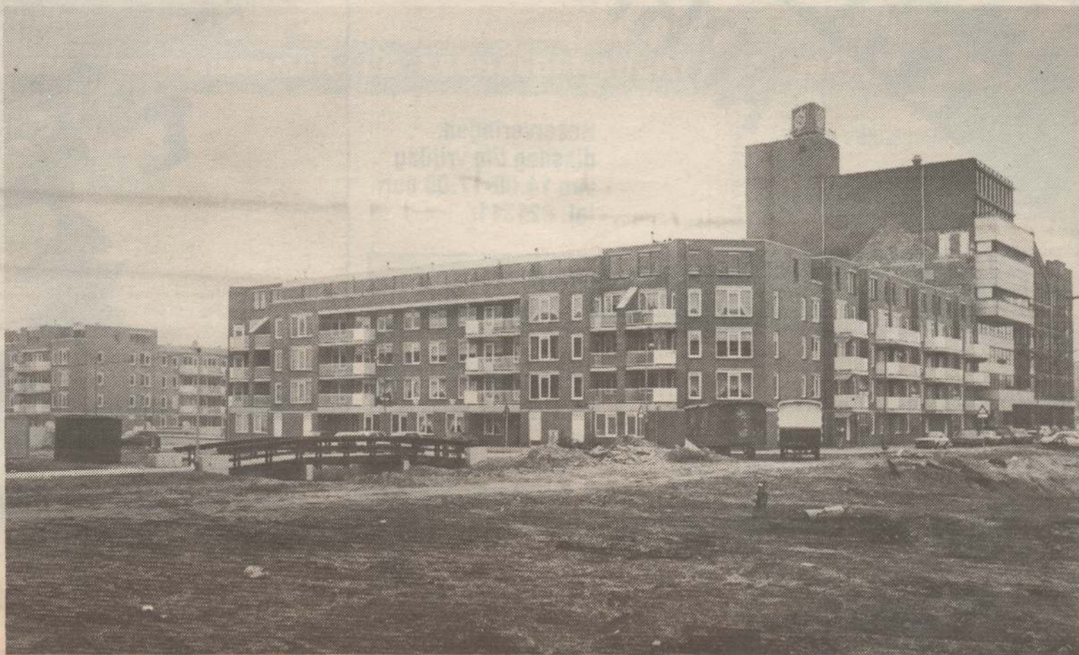
Nieuwbouw op het terrein van „de Wester” anno 1985.
