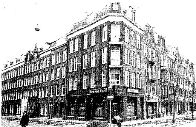
Projekt nr 17: 'De U-vorm' Fr. Hendr.plts., L. Tripstr, Fagelstr. zou in mei a.s. gesloopt worden en dat wordt nu 1986.
