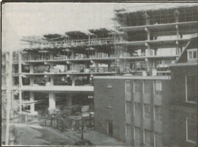
Foto 3. "De Poort" in aanbouw.
