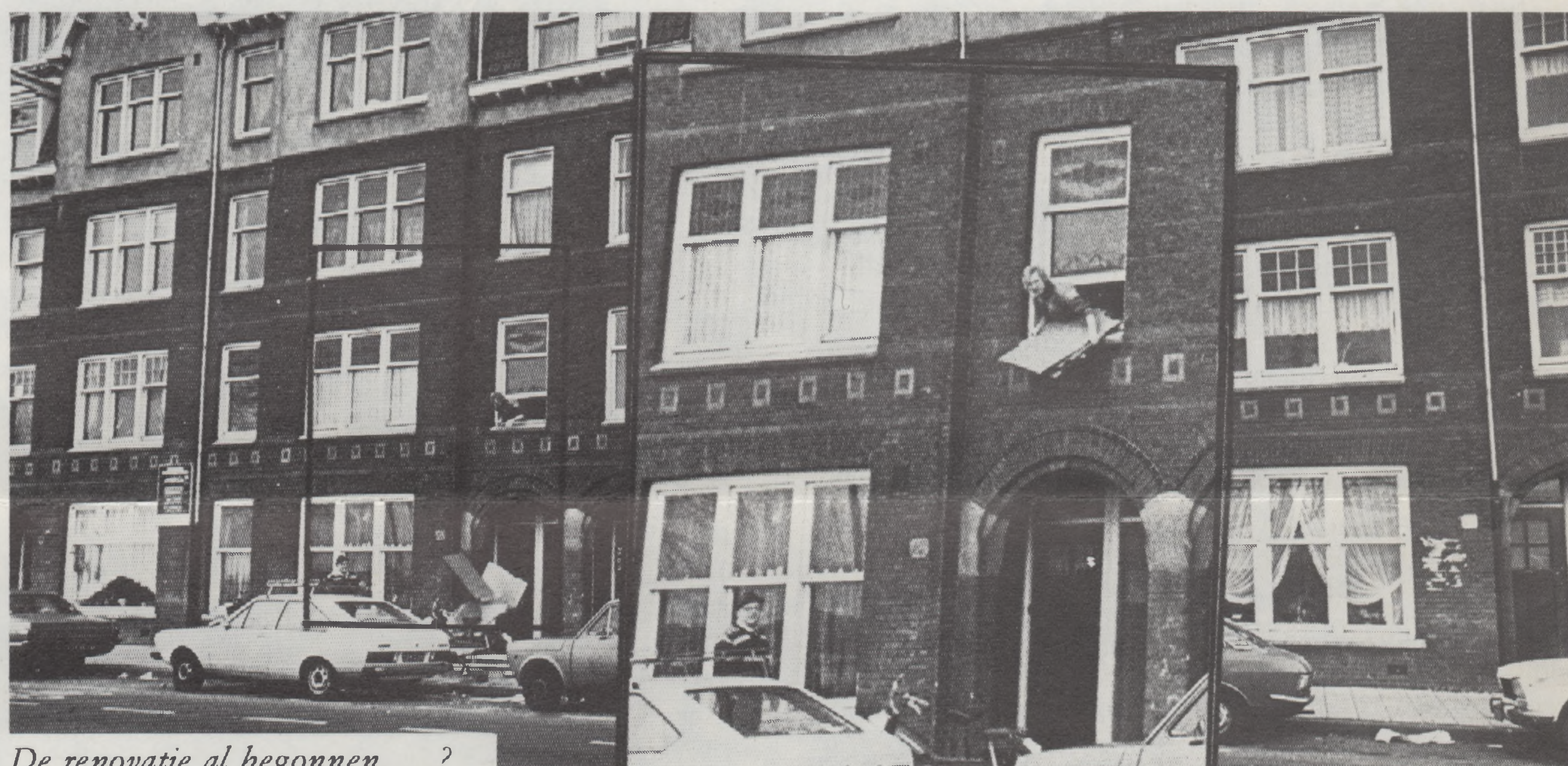
De renovatie al begonnen. . .?
