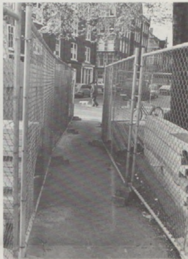
Het looppad bij de bouw.
