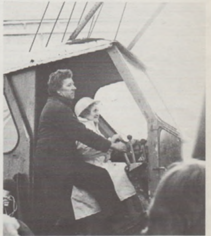
Dien van Dijk slaat de eerste paal
