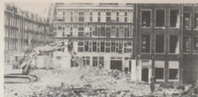
Sloop eindelijk begonnen
