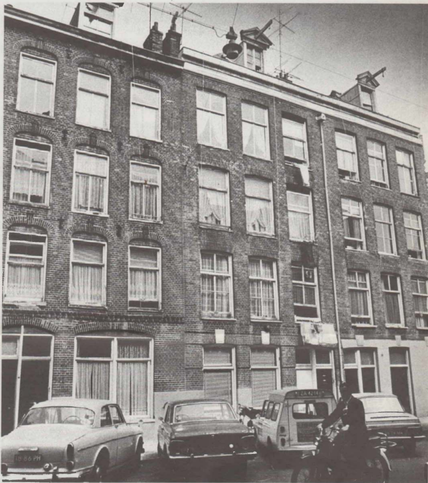
Ernstig verwaarloosde huizen in de Polanenstraat
