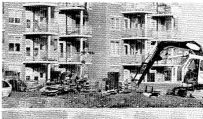
Werkzaamheden aan de sterrenwacht op de Kop van Jut.
